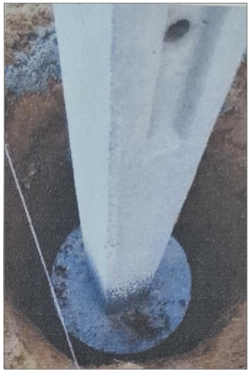
PILAR APOYADO SOBRE PIEZA PREFABRICADA DE HORMIGÓN
